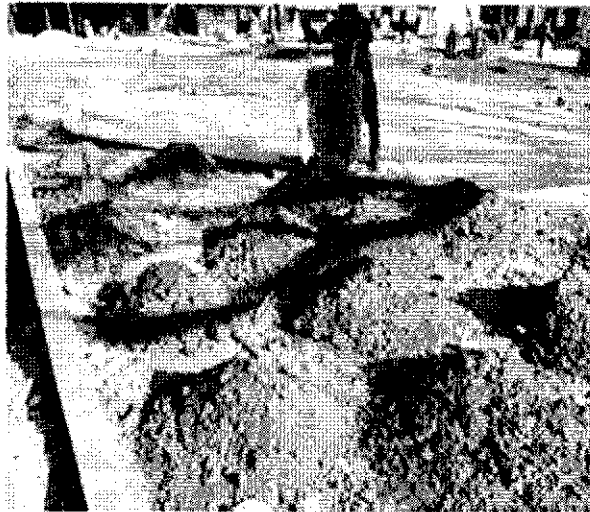
Ilustración 4 Relleno en Material Seleccionado, diferentes espesores para Nivelación Terreno. Incluye: Extendida, nivelación, Humedecimiento y compactación
