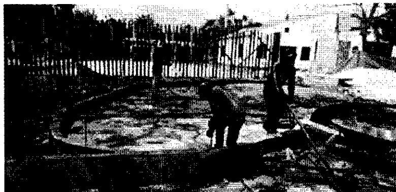
Ilustración 6 Muros bajos de confinamiento en concreto de 3000 psi de 0.15 x 0.70
