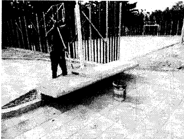
Ilustración 6 Pintura en gris basalto a dos manos
