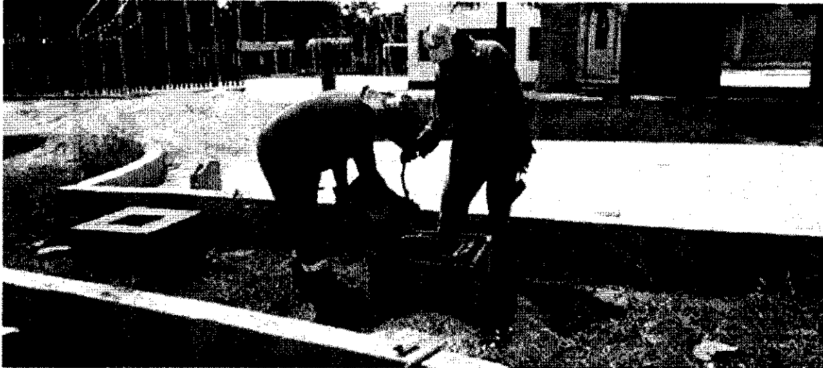
Ilustración 8 Registro de inspección AP-280
