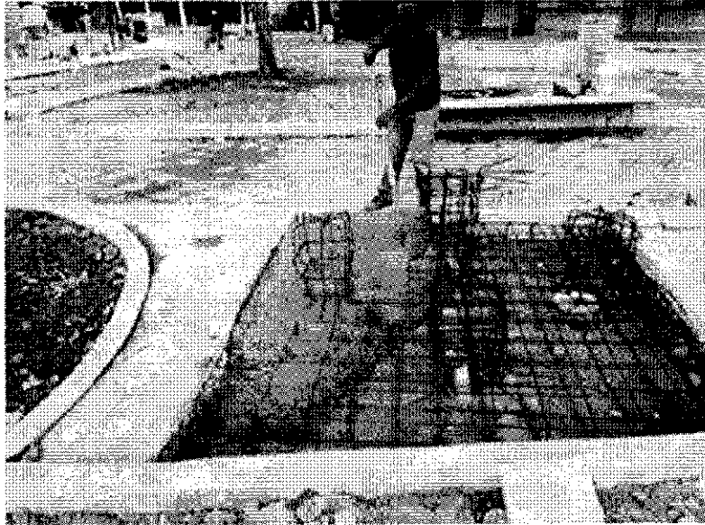
Ilustración 6 Instalación mesas de ajedrez
